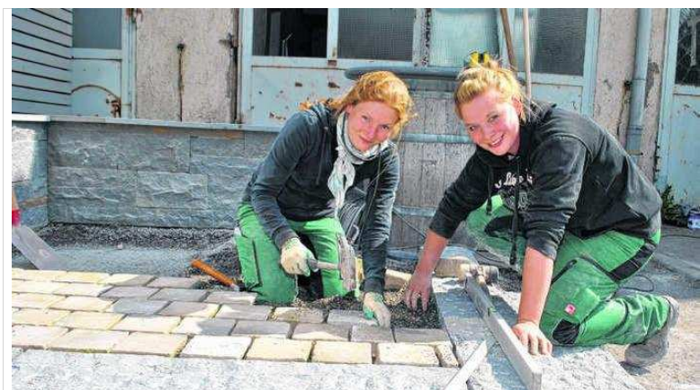
Die Vorbereitung für die „Immendinger Garten-Tage“ laufen auf Hochtouren: Gartenbaumeisterin Janine Mantik (links) und die Auszubildende Sandra Dreier von der Firma Vividus GaLa aus St. Georgen pflastern ein Podest aus Natursteinen. Bild: Jürgen Müller
